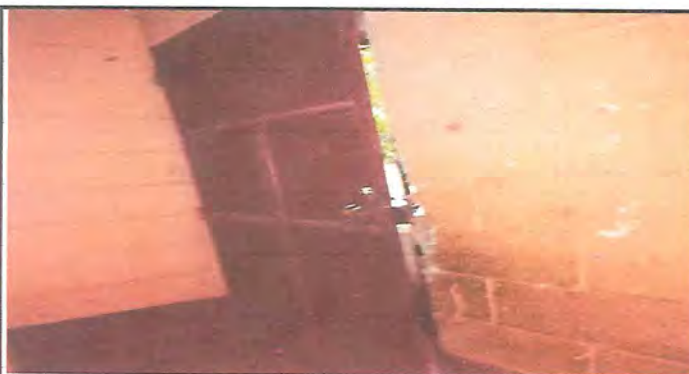
Foto 3: REMOZAMIENTO DE PUERTA
