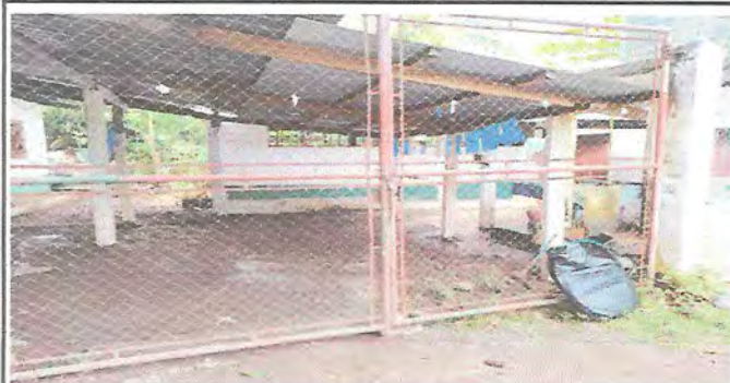
Foto 1: REMOZAMIENTO DE PINTURA DE PORTON
