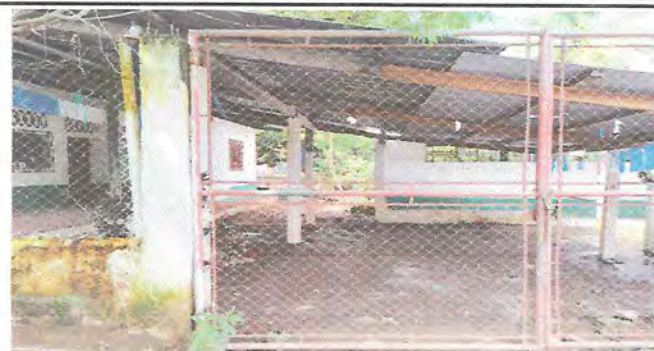
Foto 2: REMOZAMIENTO DE PINTURA DE PORTON
