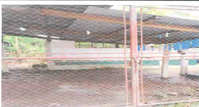
Foto 5: REMOZAMIENTO DE PINTURA DE BALCONES
