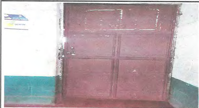
Foto 1: REMOZAMIENTO DE PUERTA
