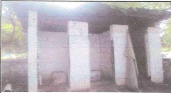
Foto 1: REMOZAMIENTO DE LOS BAÑOS
