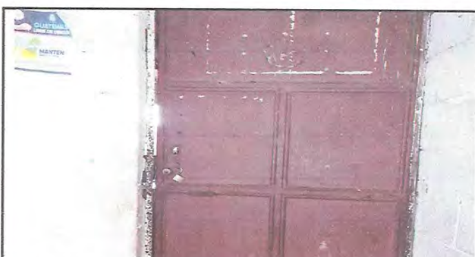
Foto 4: REMOZAMIENTO DE PUERTA
