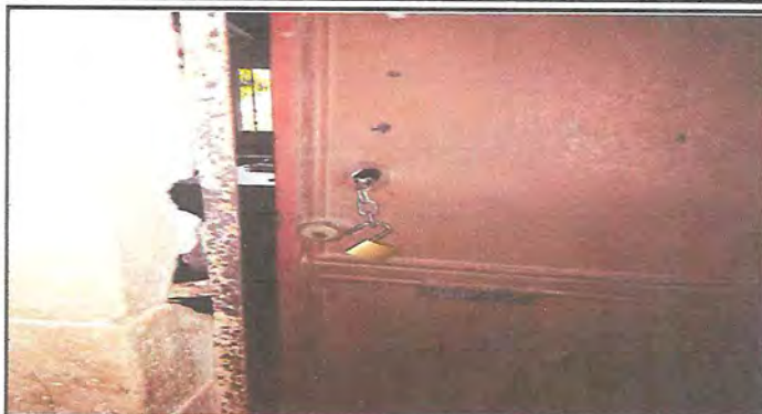
Foto 2: REMOZAMIENTO DE PUERTA
