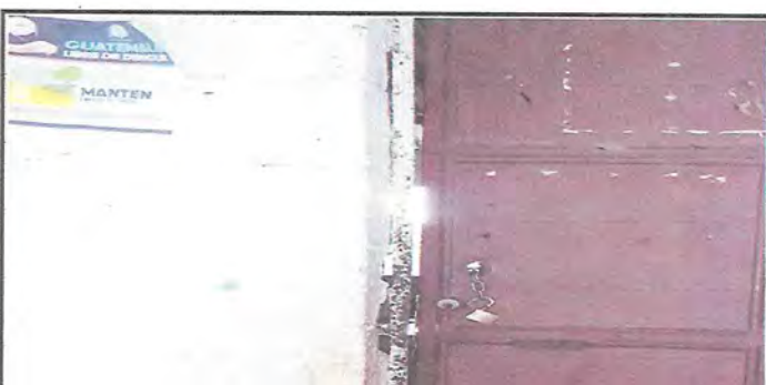
Foto 6: REMOZAMIENTO DE PUERTA
