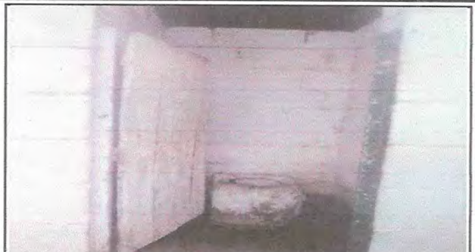
Foto 2: REMOZAMIENTO DE LOS BAÑOS
