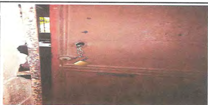
Foto 5: REMOZAMIENTO DE PUERTA
